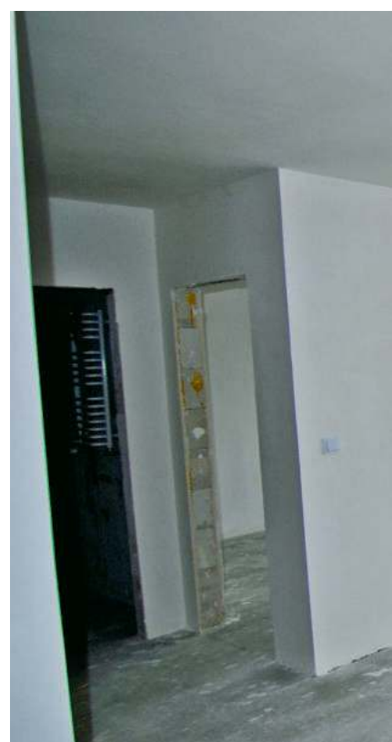
Pierwsze prace budowlane przy budowie mieszkań w Radomiu
