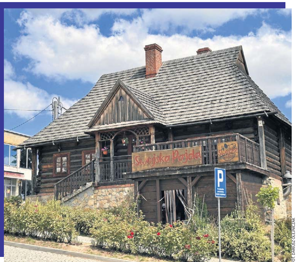
Przykład drewnianej zabudowy w Pruchniku.
