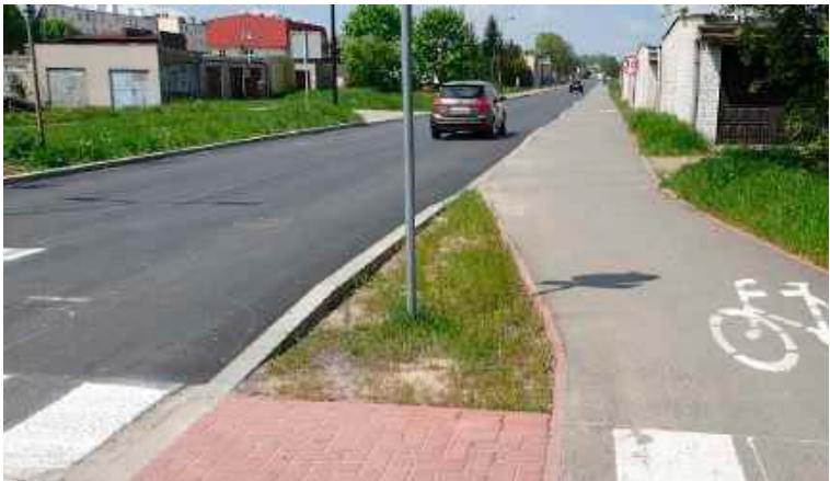
Dzięki przebudowie kierowcy zyskali nową, równą nawierzchnię, piesi chodnik, a rowerzyści ścieżkę
