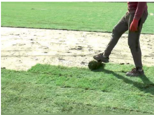
W ostatnich dniach pracownicy rozkładali rolki z trawą. Nawierzchnia musi być regularnie podlewana, by dobrze się ukorzeniła. Koniec prac został zaplanowany na koniec maja
