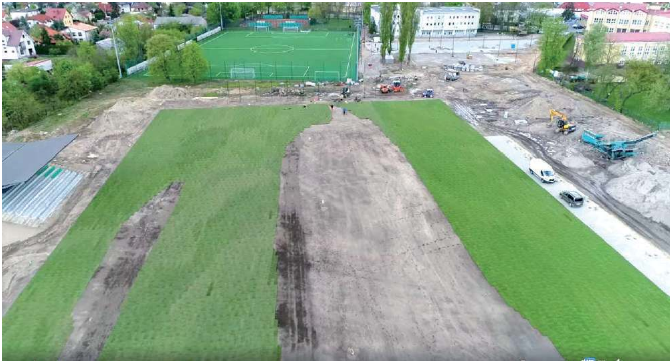
Budowa płyty kosztuje nas 3 miliony 200 tysięcy złotych
