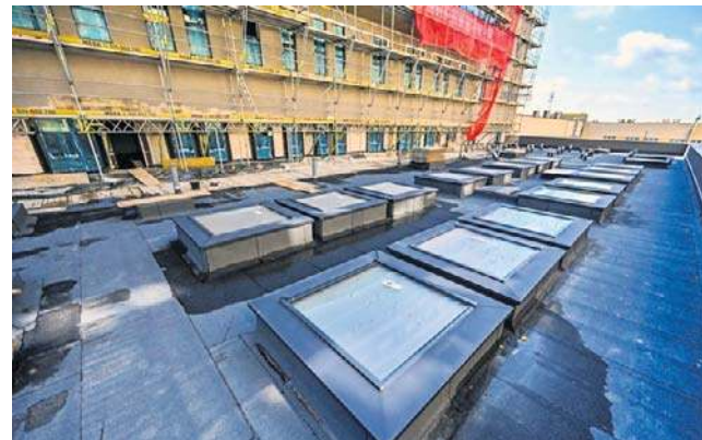
Prace na budowie wstrzymano w 2024 roku
