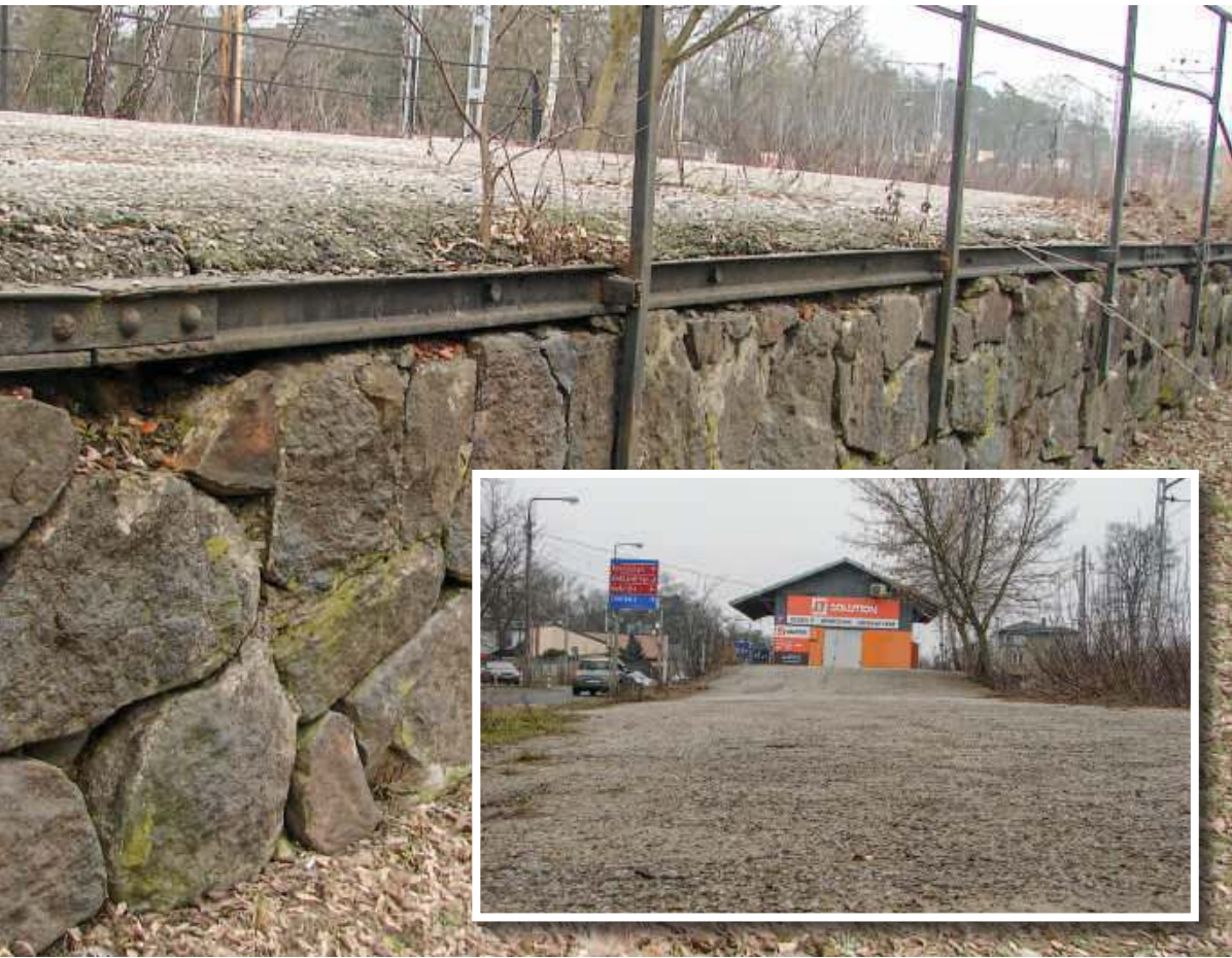
Rampa z magazynem przy stacji PKP Warszawa Falenica oraz konstrukcja boku rampy | fot. Janusz Sujecki/Gazeta Polska
