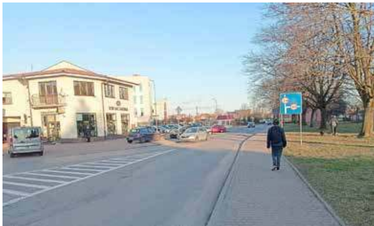
ul. Puszkina przewidziana jest do remontu
