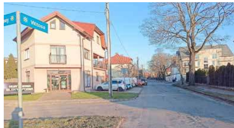
Ulica Witosza - stan nawierzchni jezdni i chodników pozostawia wiele do życzenia
