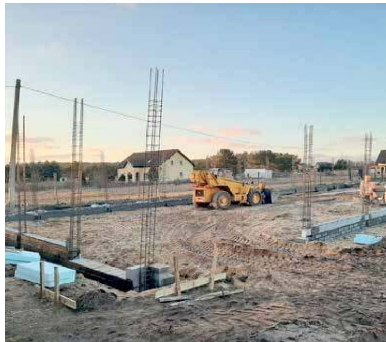
Prace budowlane w Modrzewiu - tu powstanie sklep Dino
