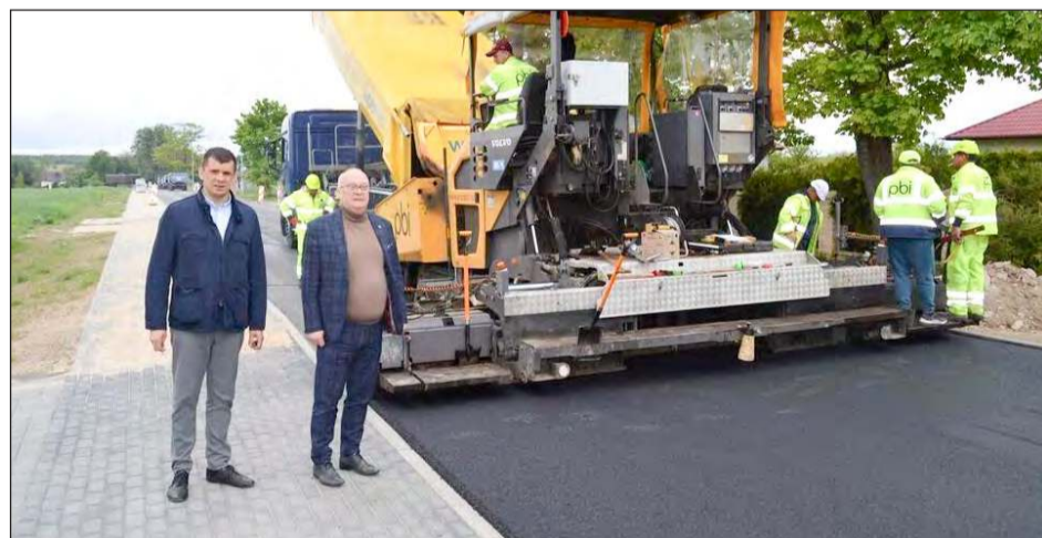
➤ Wykonawca rozpoczął układanie warstwy ścieralnej nawierzchni jezdni
