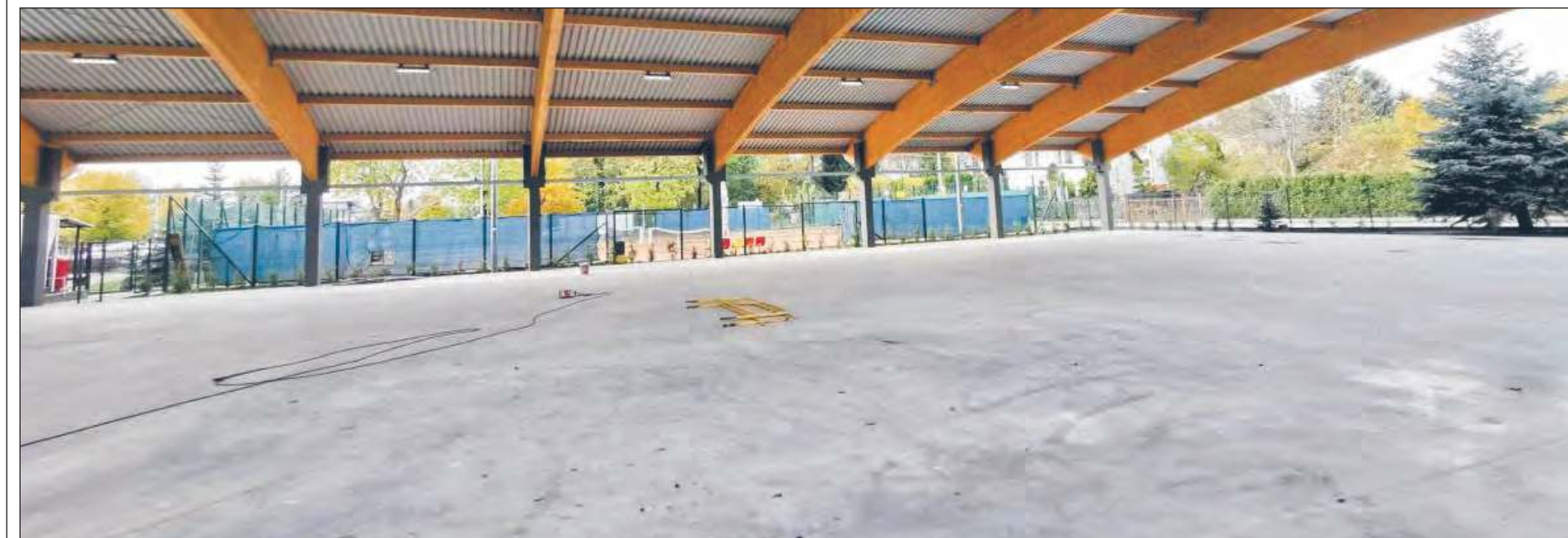
GARWOLIN Budowa krytego lodowiska w Garwolinie zbliża się do końca. - Prace są realizowane zgodnie z harmonogramem. Planujemy pod koniec listopada wylać płytę i w grudniu oddać lodowisko i informuje burmistrz Garwolina Marzena Świeczak. Obiekt powstaje przy ulicy Olimpijskiej, w pobliżu pływalni Garwolina i stadionu GKS Wilga Garwolin. Ma funkcjonować w sezonie zimowym. W sezonie letnim będzie służył jako boisko treningowe. Roboty realizuje miejscowa firma "Rembud" Kazimierza Jasińskiego. Umowa z wykonawcą opiewa na prawie 8 mln zł. Miasto pozyskało na ten cel 3,9 mln zł z samorządu województwa mazowieckiego. bc2793d64
