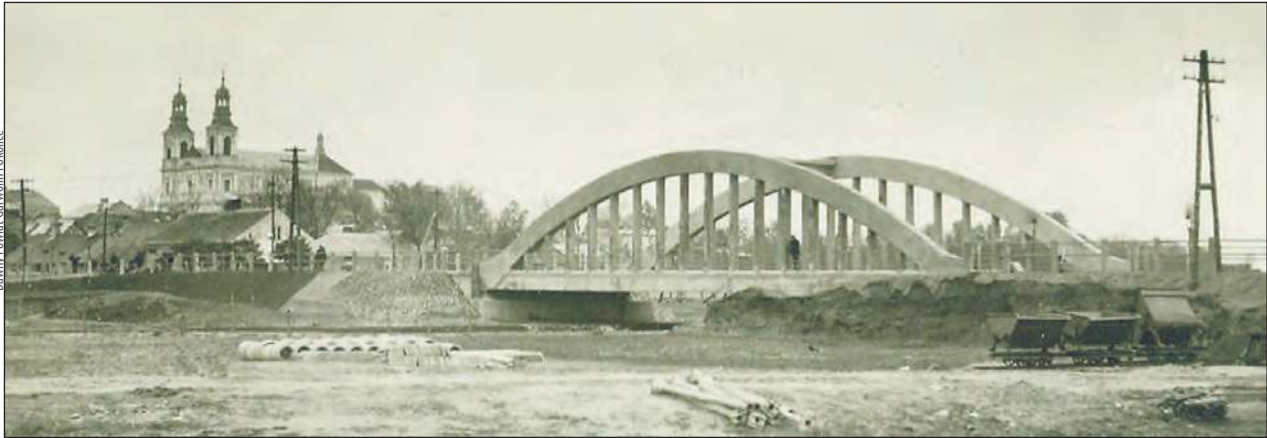
➤ Most betonowy z łukami na rzece Wildze był ważnym elementem infrastruktury Garwolina (1935 r.)
