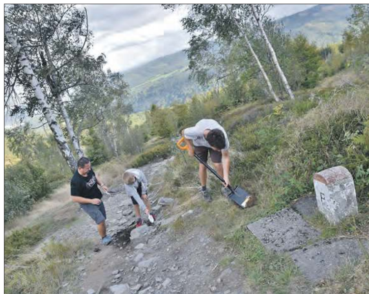
Słup zabezpieczony został 21 września
