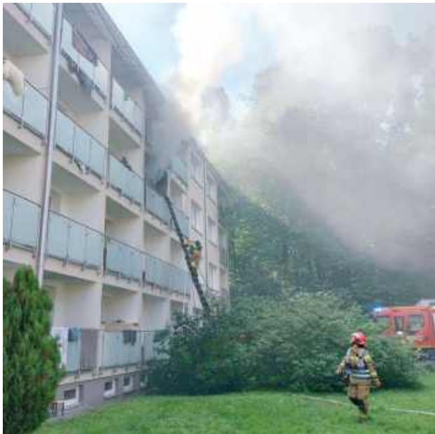
Ogień pojawił się na drugim piętrze i bardzo szybko objął część kondygnacji
