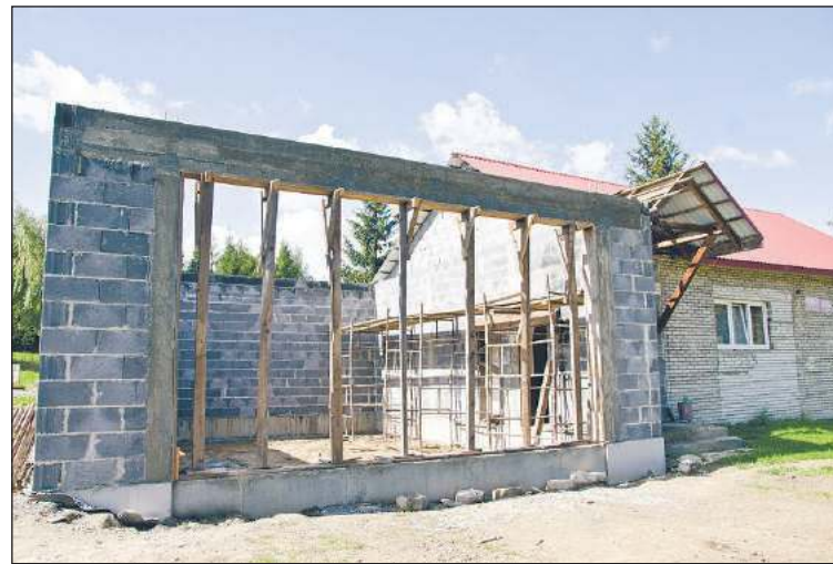
Garaż powstaje w miejscu, gdzie była wiatra wraz z podłogą do tańczenia.
