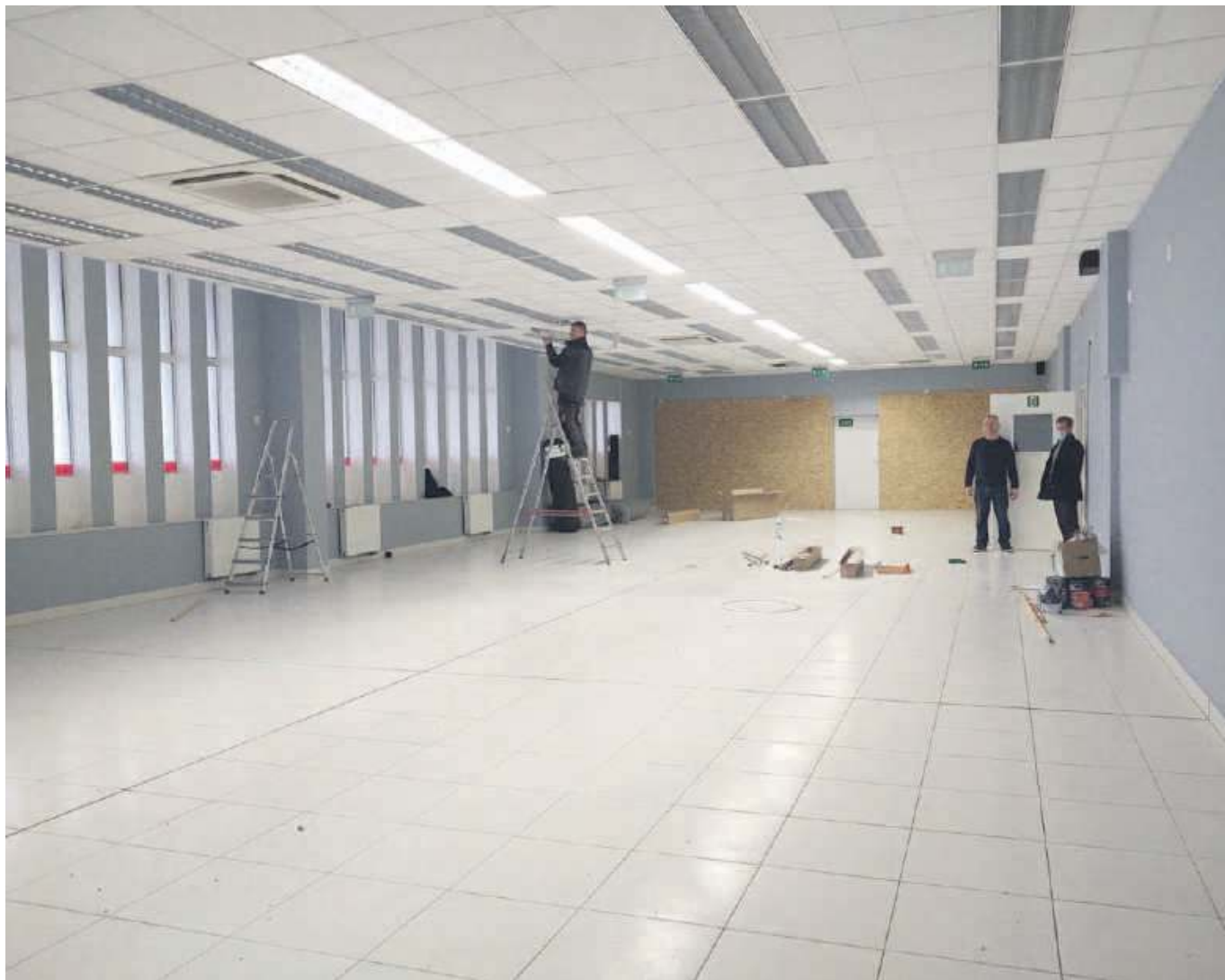
Remont sali w budynku dworca PKS ma się zakończyć do 30 listopada
