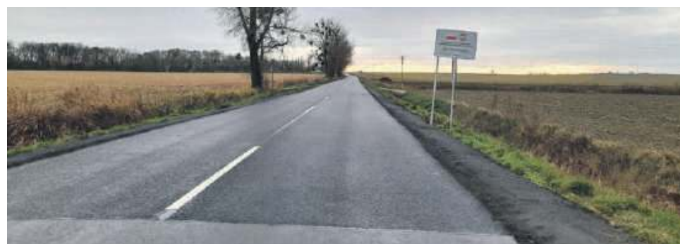
Przebudowana droga powiatowa nr 1565D.
