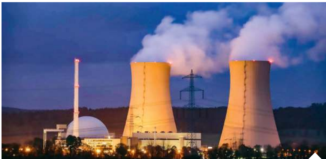
Jądrowa elektrownia w Grohnde – jedna z trzech zamkniętych w Niemczech z końcem 2021 r. | fot. Wikipedia/d
