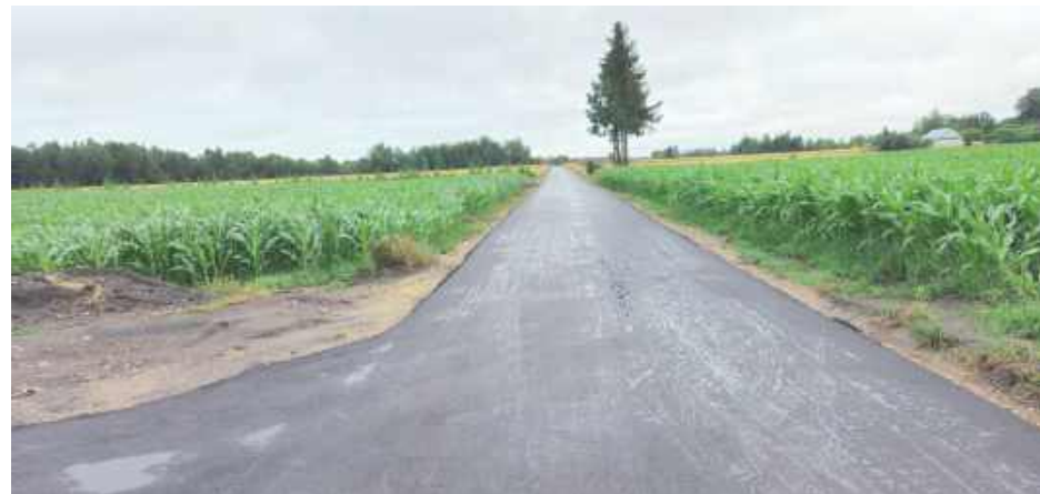
W Olszewnicy gotowa jest już pierwsza warstwa nawierzchni
