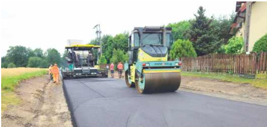
Prace w Turowie idą pełną parą
