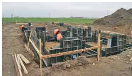
Budowa stacji uzdatniania wody rozpoczęta
