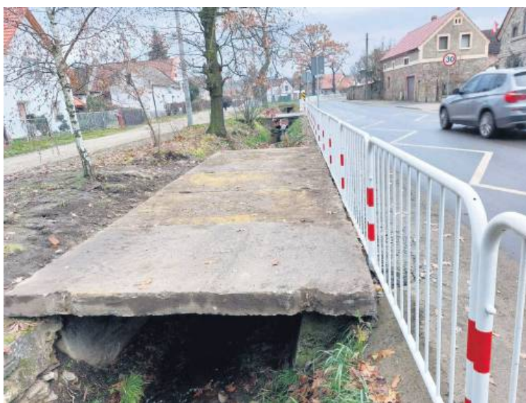
Powiatowy Zarząd Dróg ustawił betonowe płyty nad rowem w Gościęcicach. Jest to efekt porozumienia między gminą Strzelin a Starostwem Powiatowym, w ramach którego gmina sfinansuje wiatę przystankową
