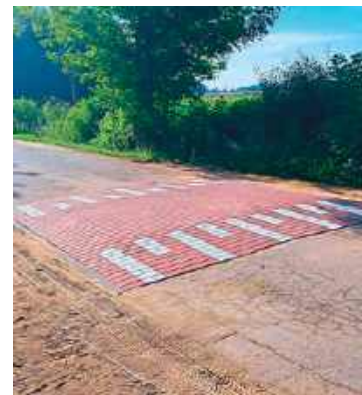
Próg po odbudowaniu
