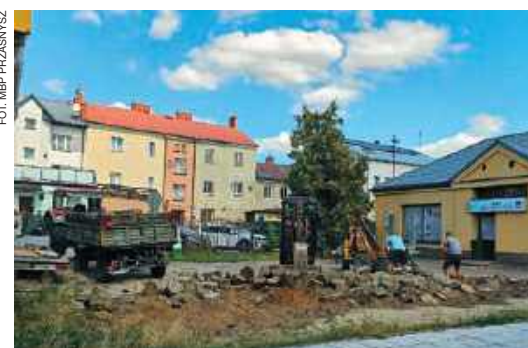
FOT. MBP PRZASNYSZ
