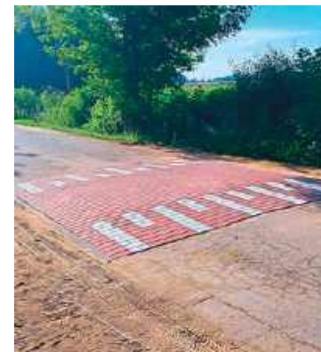
Próg po odbudowaniu
