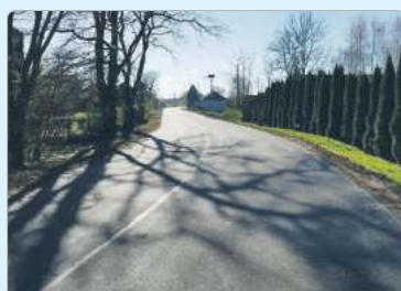
Remont drogi powiatowej Maciejów Nowy - Żabno - Wierchowina
