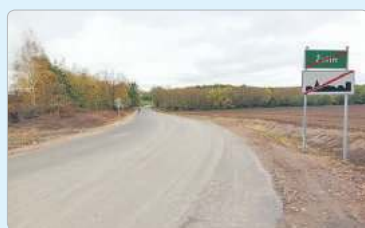
Przebudowa drogi powiatowej nr 3122L Łopiennik - Żulin
