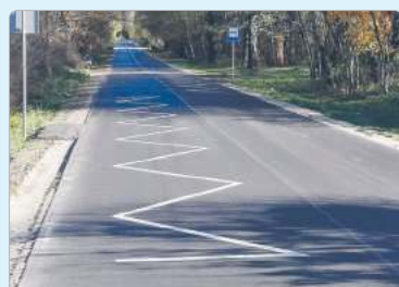
Remont drogi powiatowej Łopiennik - Żulin - Rejowiec
