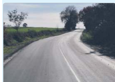
Remont drogi powiatowej Wola Żulińska - Józefów - Kasjan
