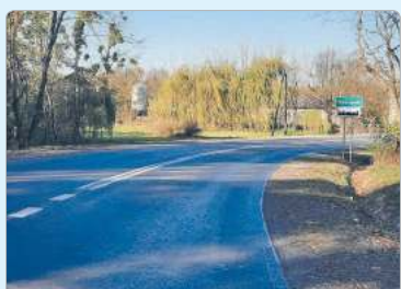
Rozbudowa drogi powiatowej Chorupnik - Rudnik - Mościska
