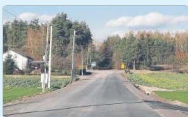
Rozbudowa i przebudowa drogi powiatowej Biskupice - Boniewo
