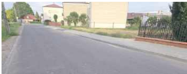
Ta prezentuje się nawierzchnia ulicy Cmentarnej po pierwszym etapie remontu
