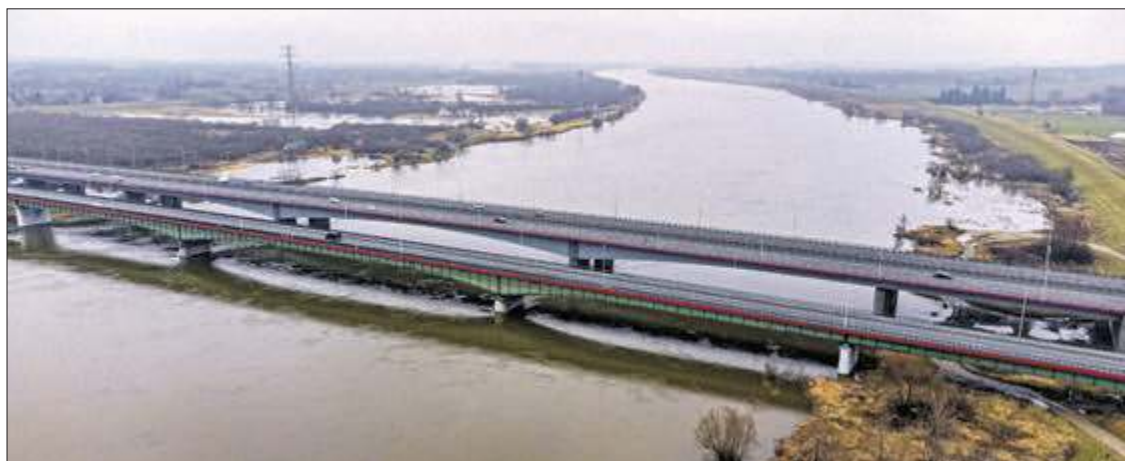
Most na Wiśle w Kieźmarku, w którego budowie brała udział firma TBM Systems
