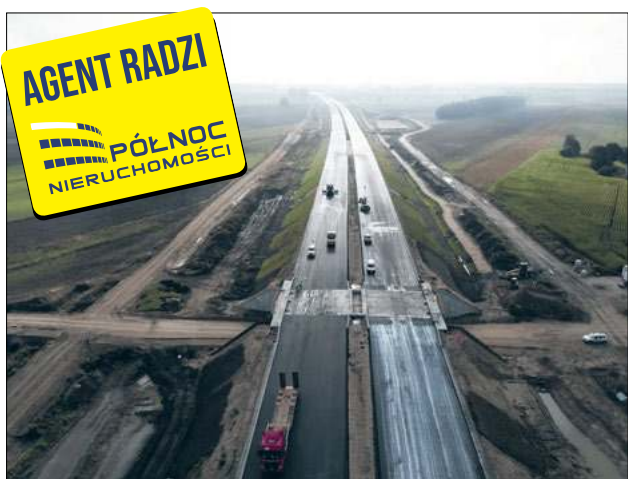
Kiedy zakończą się budowy najważniejszych nitek komunikacyjnych, Biała Podlaska, Chełm i Zamość zyskają szansę na rozwój w branży nieruchomości
