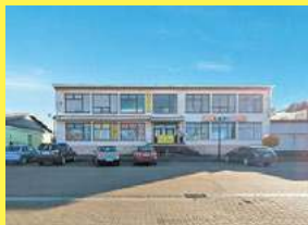
Dom handlowy w samym centrum Janowa Podlaskiego, 885 851 161
