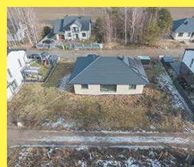
Dom z pompą ciepła i fotowoltaiką - Porosiuki, 604 494 489
