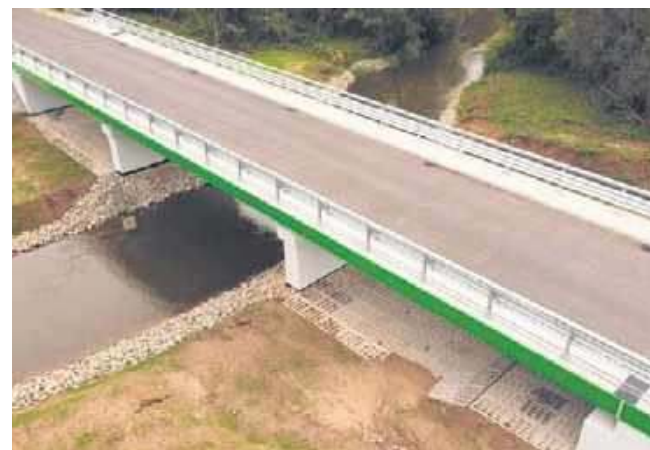
Nowy most w Budzynie w gm. Radymno w miejsce starego, który od lat już wymagał remontu
