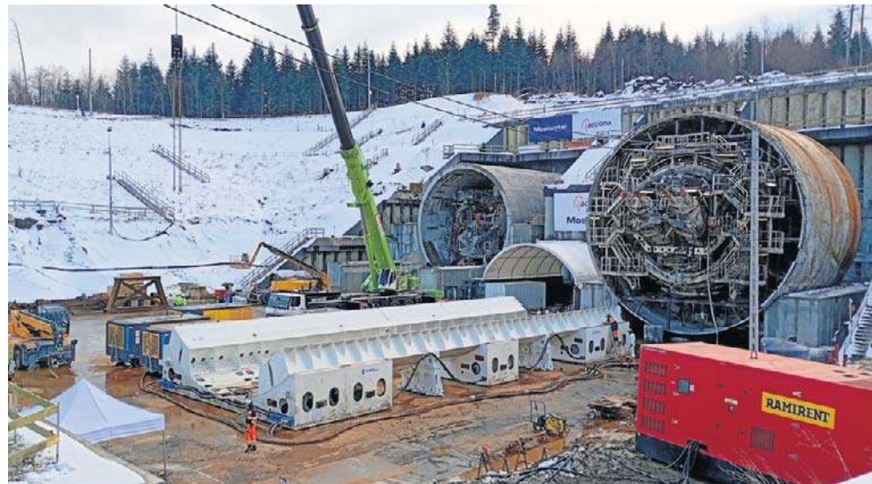
Najbardziej spektakularną fazą operacji jest przeniesienie i obrócenie tarczy TBM
