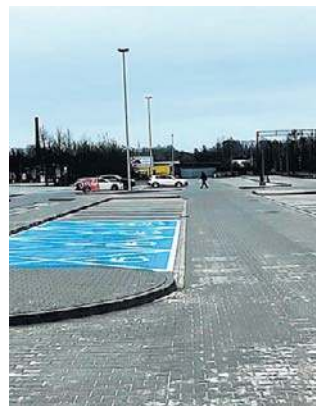
Parking pomieści 85 samochodów
