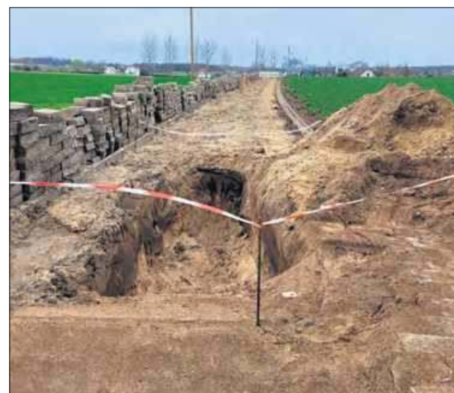
Powstaje nowy odcinek wodociągu i sieci kanalizacyjnej.
