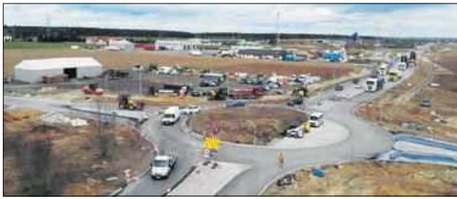
Zakres inwestycji obejmuje rozbudowę drogi krajowej nr 45, w tym m.in. budowę dwóch rond.
