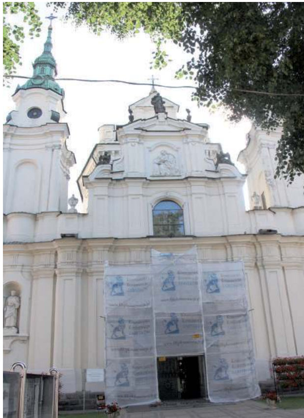
Przy kościele św. Anny poddawany jest konserwacji portal wejściowy
