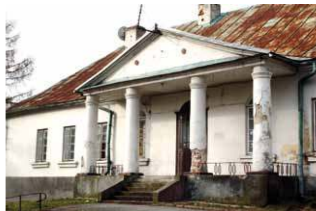
Są środki na remont Bajki w Tylmanowej.
