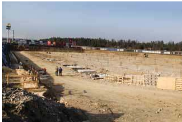
Postęp prac przy budowie Galerii Podhalańskiej.
