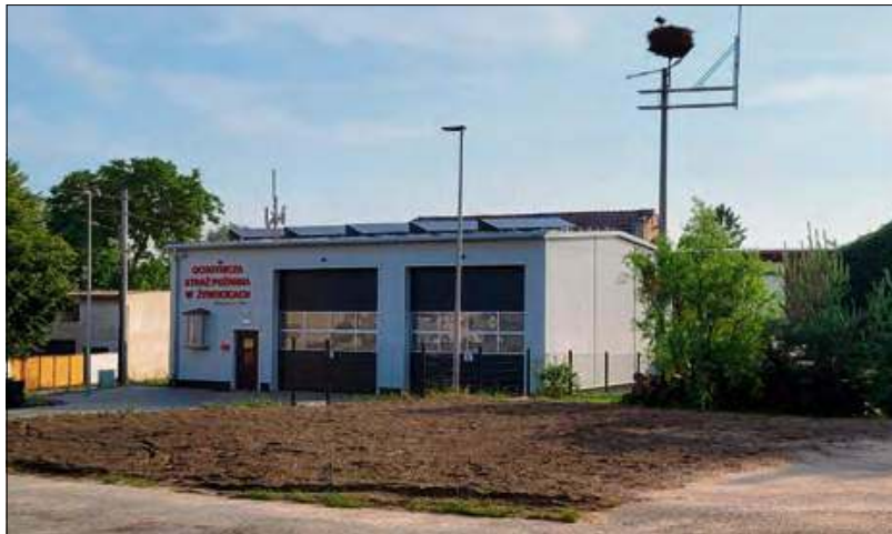
Rozebrano budynek starej remizy w Żywocicach, który ochotnikom służył od 1889 roku.
