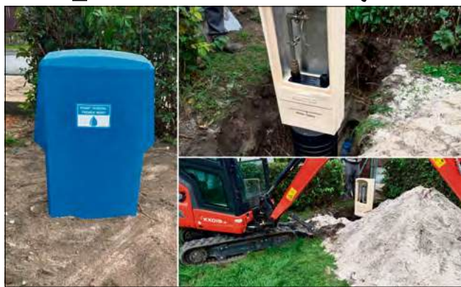
Montaż szafek do poboru próbek wody ma ograniczać wpływ wewnętrznych instalacji na jakość pobieranych próbek.
