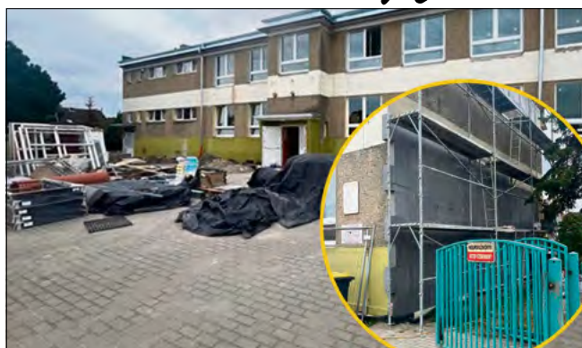
Trwa termomodernizacja budynku szkoły w Kątach Opolskich.
