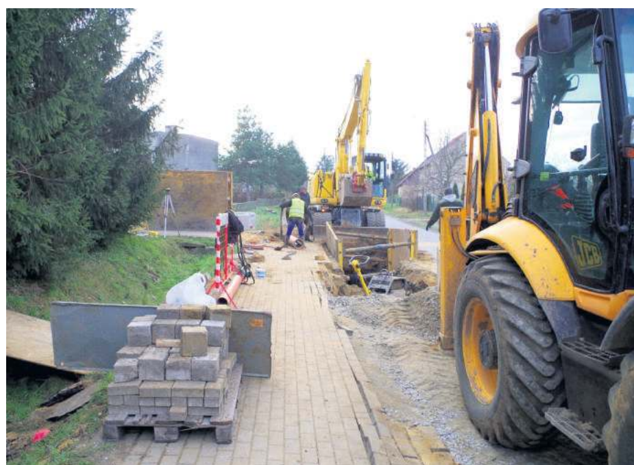
Wykonano już m.in. sieć ciśnieniową kanalizacji sanitarnej z przepompowni w Karszowie do studni rozprężnej na terenie Mikoszowa
