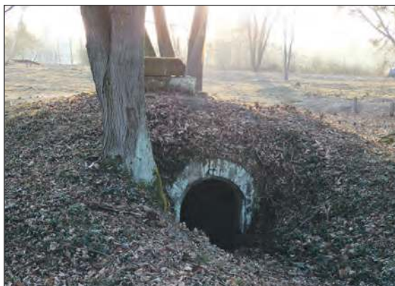
➤ W trakcie prac udało się odsłonić nie tylko nagrobki, ale i całe grobowe piwnice (fot. Jarosław Frąckiewicz)
