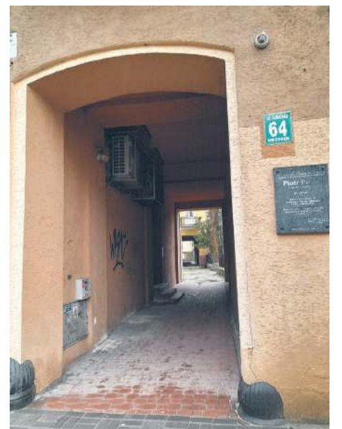
Jedyny dojazd i „dojazd” do mieszkań w podwórzu
