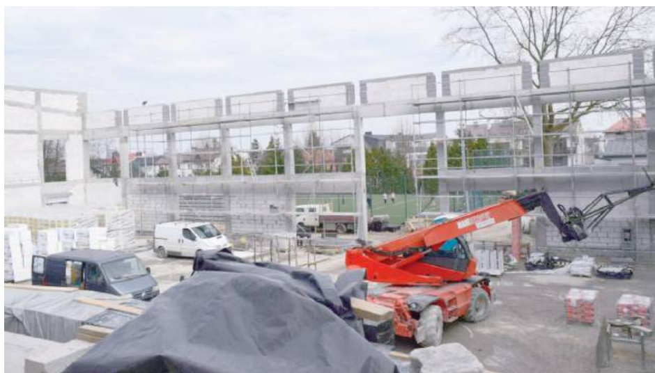
W Biłgoraju trwa budowa Centrum Rehabilitacyjno-Sportowego przy SP nr 1
