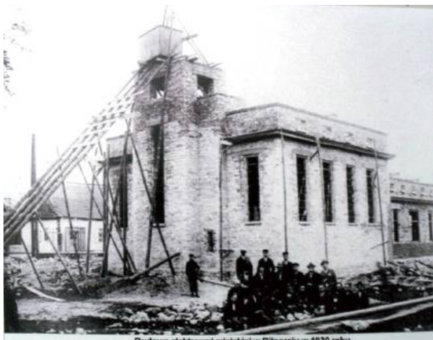
Budowa elektrowni w Biłgoraju (1930 rok)
