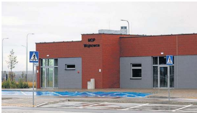
MOP Wojnowce będzie pełnił funkcję parkingu buforowego dla pojazdów oczekujących na odprawę graniczną
