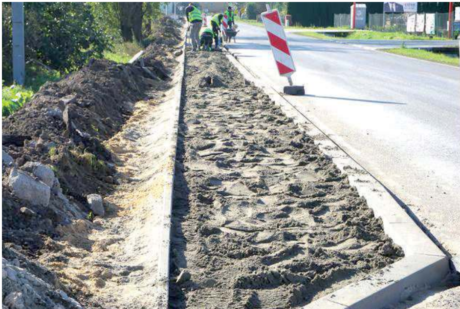
Prace ruszyły na początku października i idą bardzo sprawnie. Spora część chodnika jest już zrobiona
