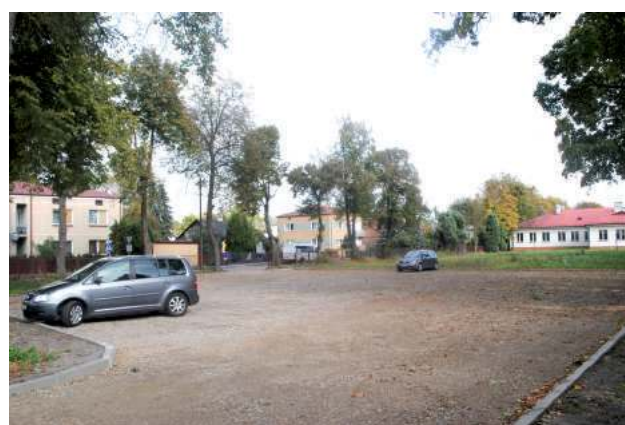
Budowa parkingu przy ul. Kolejowej rozpoczęła się w połowie września. I zgodnie z umową wykonawca miał zostać ukończona do końca października. Zakończył się jednak wcześniej
