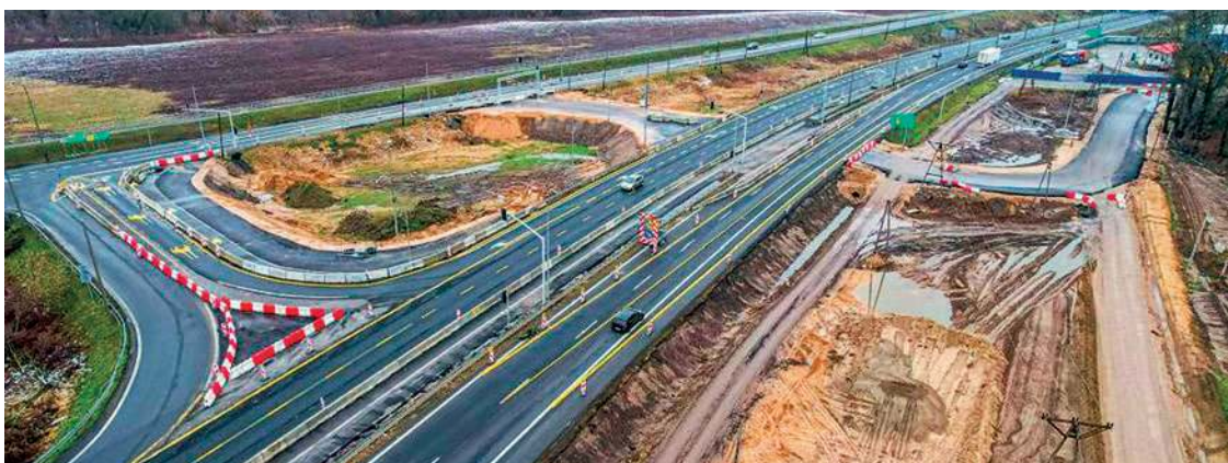
Roboty drogowe na „siódemce” są już bardzo zaawansowane
