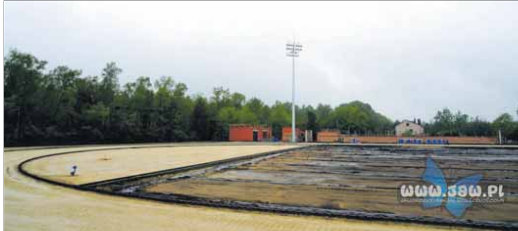
Budowa stadionu lekkoatletycznego w Jaworznie
