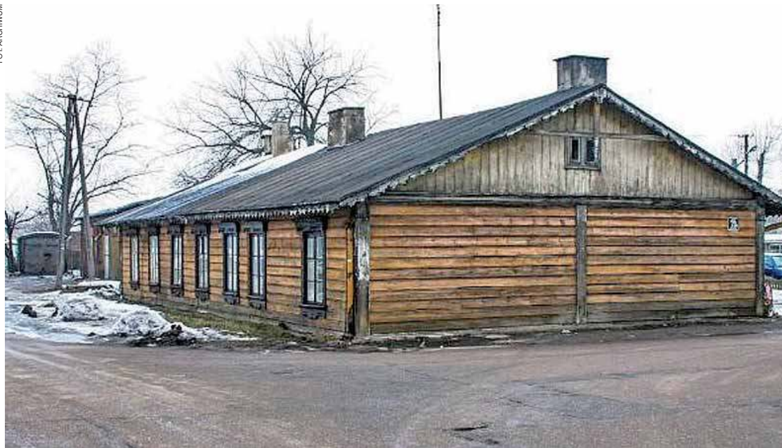
Zabytkowy budynek kolejowy postawiono w 1880 r.
