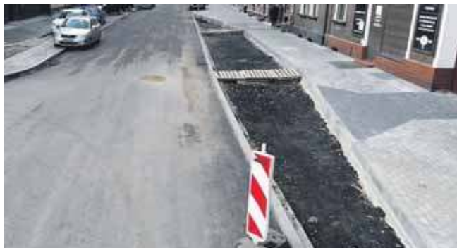
W najbliższych dniach mają zostać wyasfaltowane zatoki autobusowe
