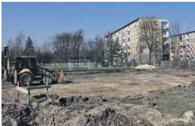
Ruszyły prace przy budowie centrum aktywności
