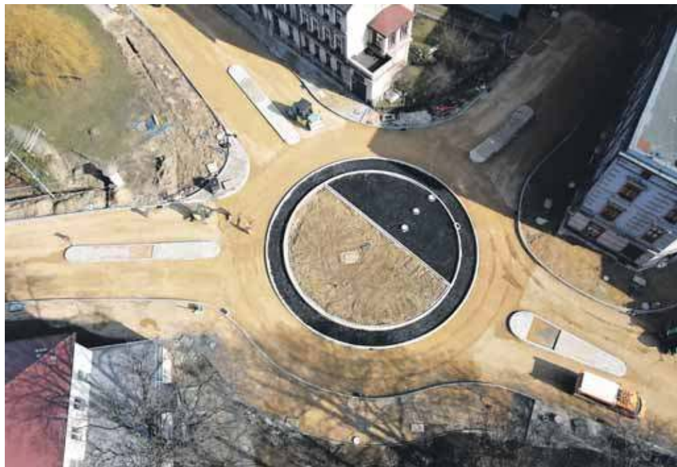
Tak wyglądało budowane rondo w ubiegłym tygodniu
