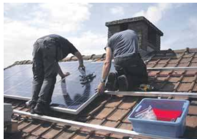
W projekcie przewidziano udzielenie grantów na dostawę i montaż 1096 instalacji OZE
