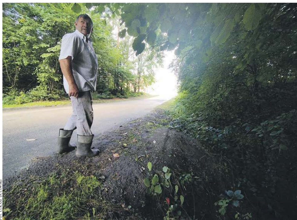
Jan Gał z Podłęża po każdej ulewie patrzy, czy asfalt na Radosnej jeszcze się trzyma
