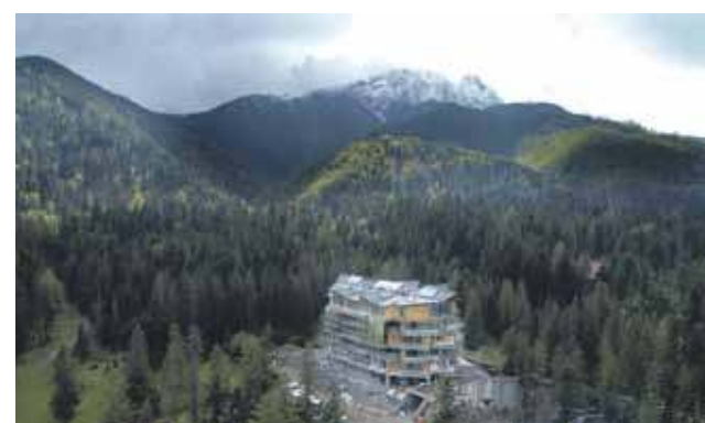
Droga do Białego. To najbardziej skandaliczna budowa w Zakopanem i w Tatrach.
