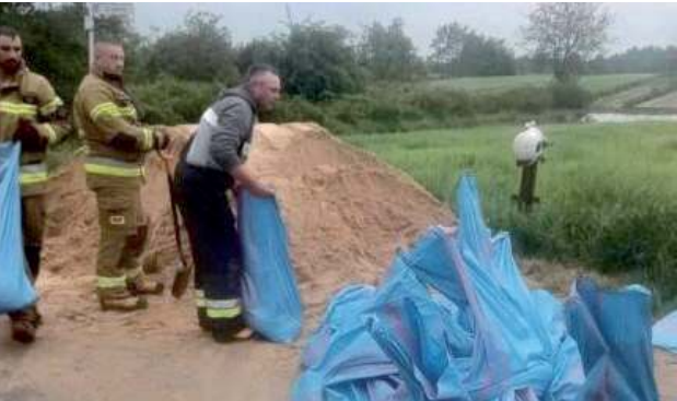
Po drugiej nawałnicy we Frampolu, miejscowi strażacy rozkładali worki z piaskiem
