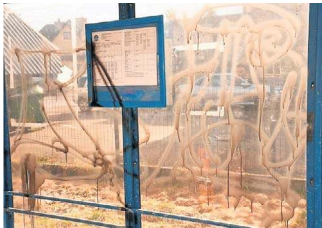
Nocne występy 20-latka w Nowym Targu zakończyły się w areszcie. Na zdjęciu zniszczona wiat przystankowa
