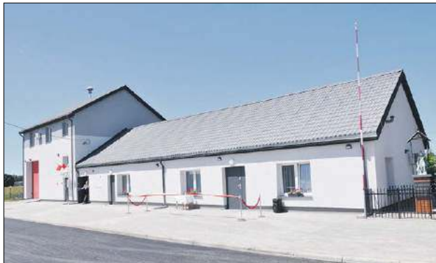
Remont budynku w Maniach wpisany jest w większy projekt o nazwie „Poprawa efektywności energetycznej budynków użyteczności publicznej na terenie gminy Międzyrzec Podlaski”
