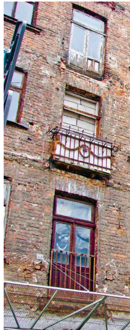
Kamienica przy ul. Wileńskiej 5 i fragment balustrady
