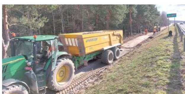
Do granic miasta dociera budowa ścieżki pieszo-rowerowej przy ul. Kodeńskiej
