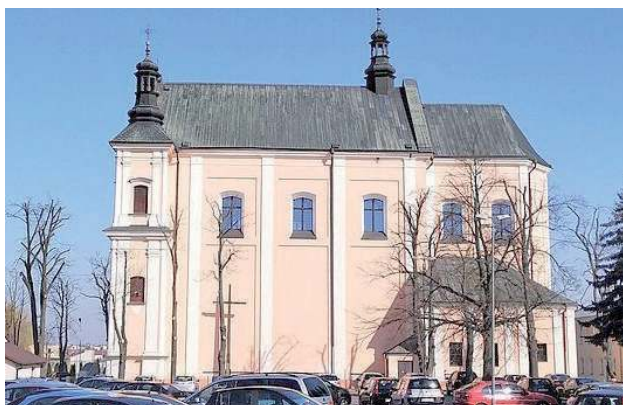
W środę, 21 lutego strażacy naprawili obłuzowany parapet przy oknie kościoła Podwyższenia Krzyża Św. w Łukowie, przy ul. Wyszyńskiego
