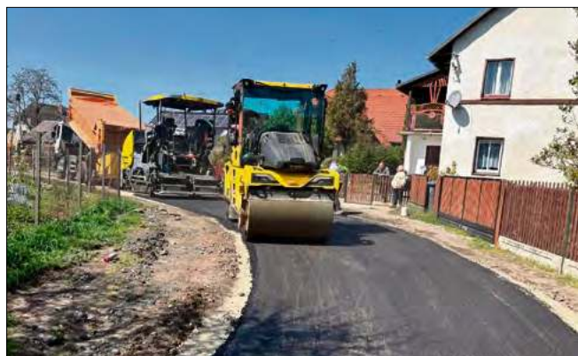
Nowa nawierzchnia na ul. Osadników w Ciepeliowicach.
