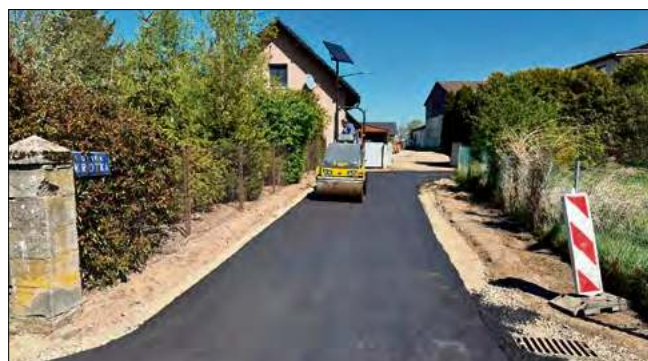
Prace na ul. Krótkiej w Ciepeliowicach.
