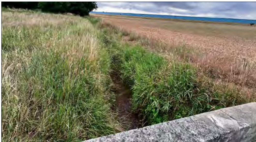
Rów w Malni też trzeba wyczyścić. To ważne zadanie związane z bezpieczeństwem mieszkańców.
