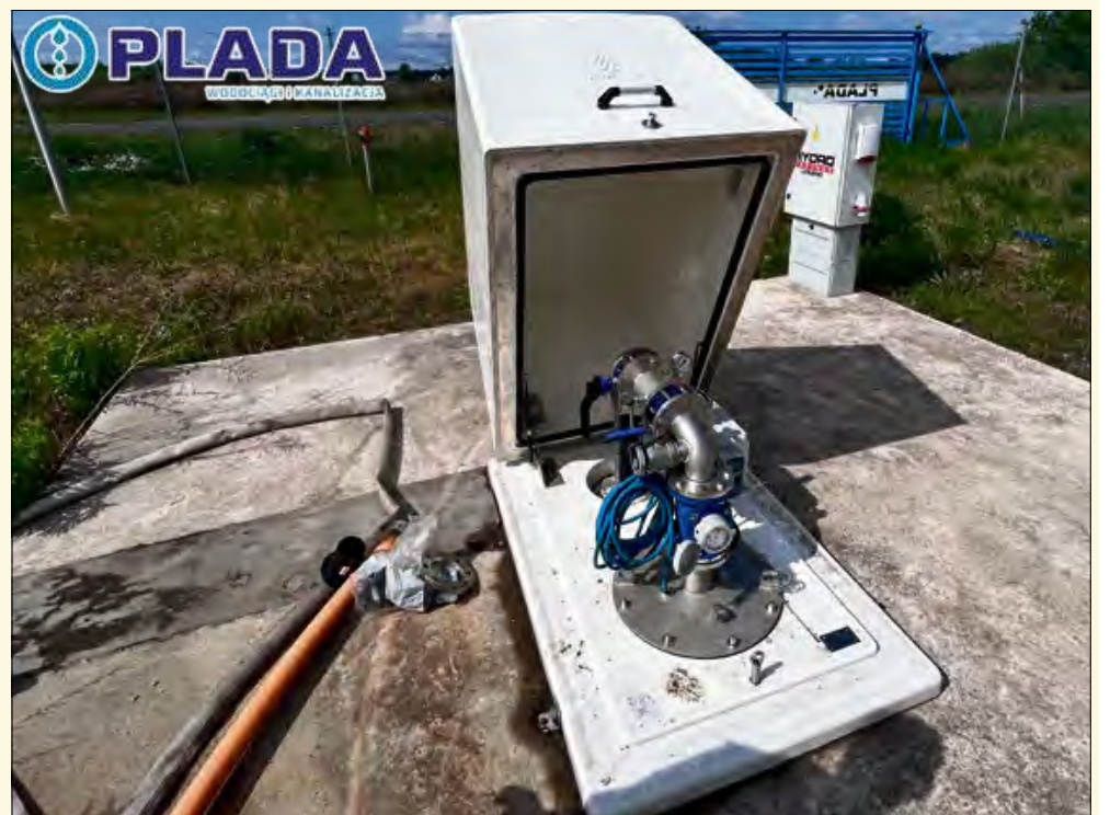
Studnia głębinowa już została wybudowana.
