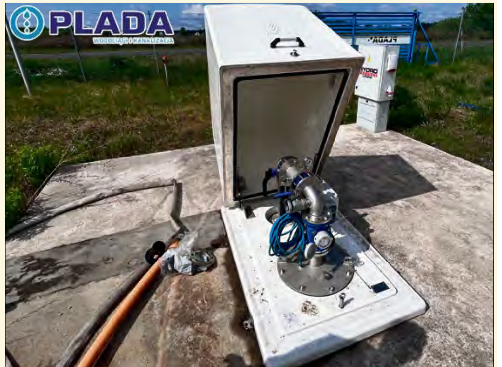
Studnia głębinowa już została wybudowana.
