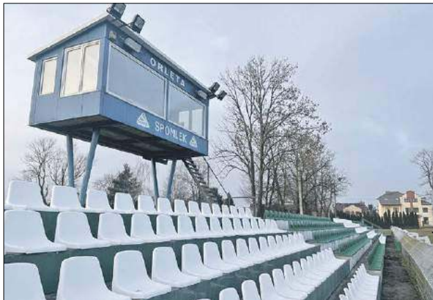
W ostatnich dniach na trybunach stadionu w Radzynie Podlaskim zakończono montaż około 1000 siedzisk dla widzów
